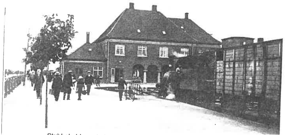
Stubbekøbing station – dengang der var stil over byen ved Bøgestrømmen. Lokomotivet er nr. 7.
